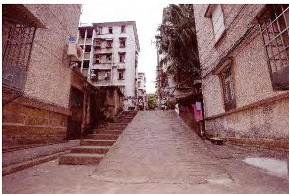
改造前，坡道两侧缺乏保护设施
