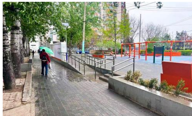
无障碍出入口改造前后 (朝阳区太阳粒子能量场)
